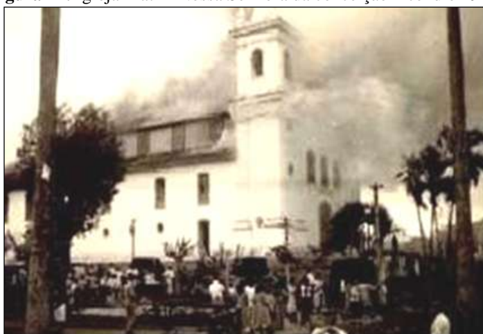
Figura 22: Igreja Matriz Nossa Senhora da conceição incêndio 1945.
