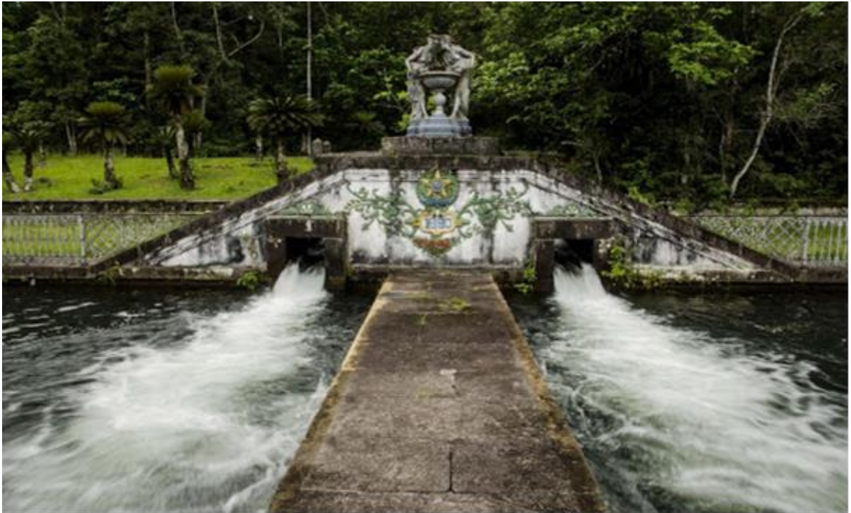
Figura 28 – Reservatório do Rio D'ouro.
