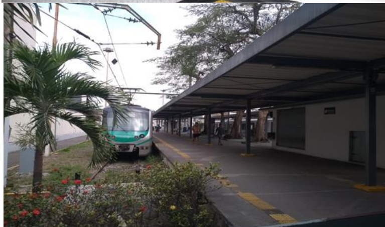
Estação de Belford Roxo em 2020.
