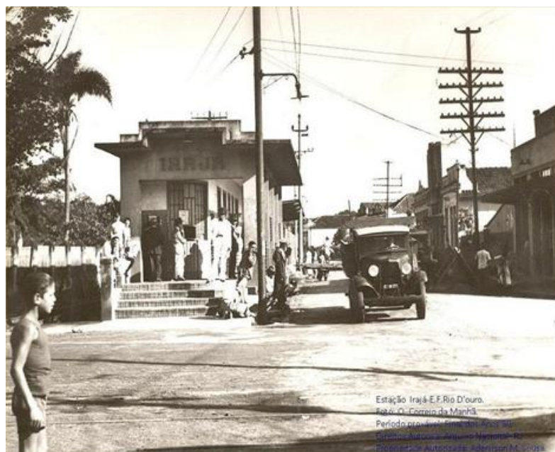
Estação Irará E.F. Rio D'ouro. Foto: O. Corrêa da Manhã. Período pro: José Simões, Arq. do Estado, Aut. do Patrimônio Histórico e Arquitetônico, Administração, M. C. 100/100. Estação Irará na década de 1960 – (novo prédio inaugurado em 1929).
