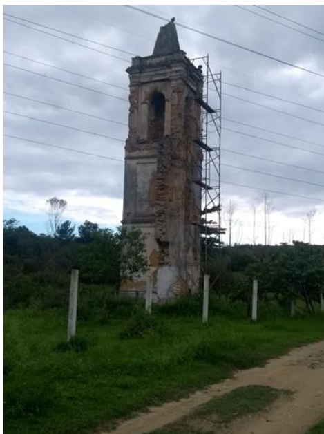
Ruínas da Igreja de Nossa Senhora da Piedade do Iguassu
