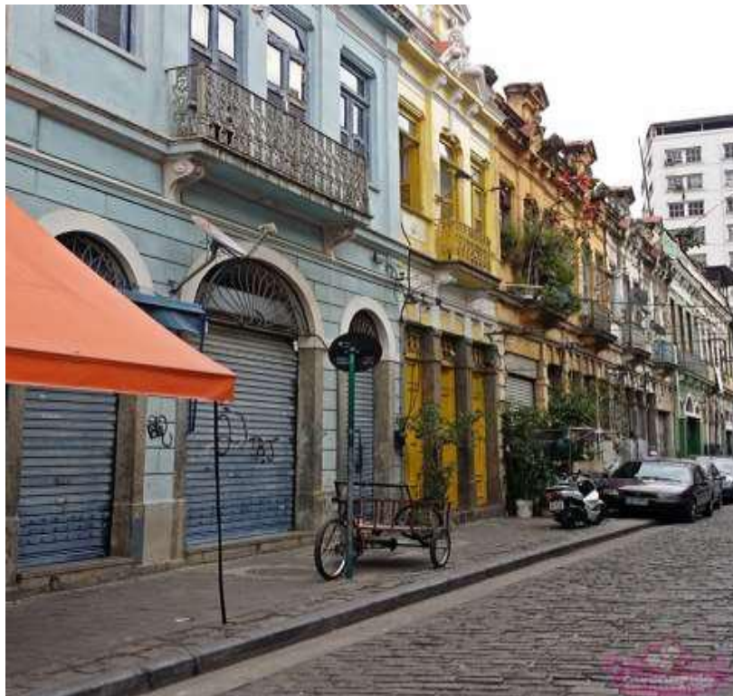
Figura 20. Prédios Listados como preservados na Rua Sacadura Cabral, no sopé do Morro da Conceição.
