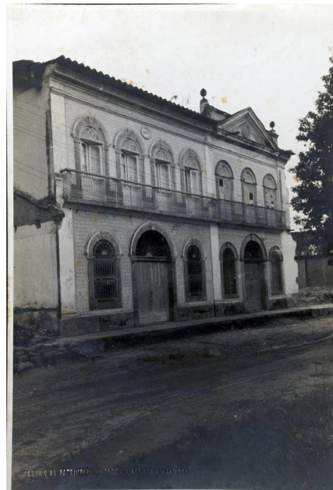
Fotografia 7: Sobrado já em processo de destruição em 1940
