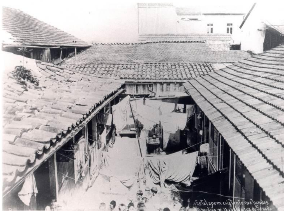
Figura 49 Foto de Augusto Malta. Legenda original: “Estalagem existente nos fundos dos prédios número 12 a 44 da Rua do Senado”. Não se pode precisar a data do registro.
