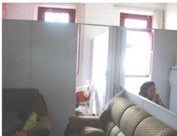
Fig.III.73 Instalação de divisórias. Foto do autor, 2008.
