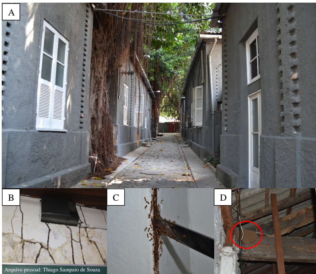
Figura 2. Danos causados por Nasutitermes corniger em prédio histórico da Universidade Estadual do Rio de Janeiro (UERJ)/ Campus Lapa, Rio de Janeiro, RJ: A. Escola Superior de Desenho Industrial; B. Túneis de N. corniger na parede interna de uma sala de aula alcançando o ar condicionado; C. Soldados de N. corniger ; D. Ninho policálico incipiente, marcado em vermelho, encontrado no telhado.
