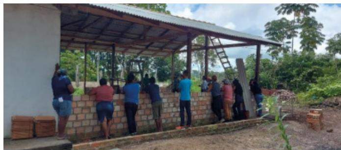
Figura 5. Barracão da fábrica de óleo no assentamento Tapera Velha, Santarém, Pará
