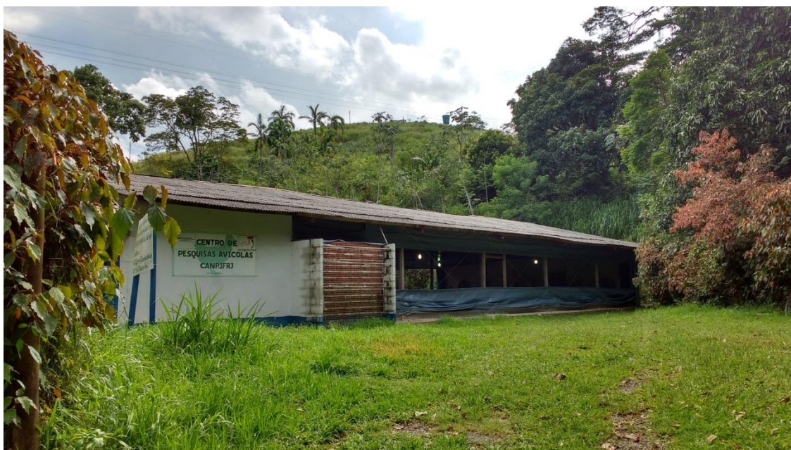
Figura 1 - Galpão experimental do Centro de Pesquisa Avícolas do IFRJ. Vista externa.
