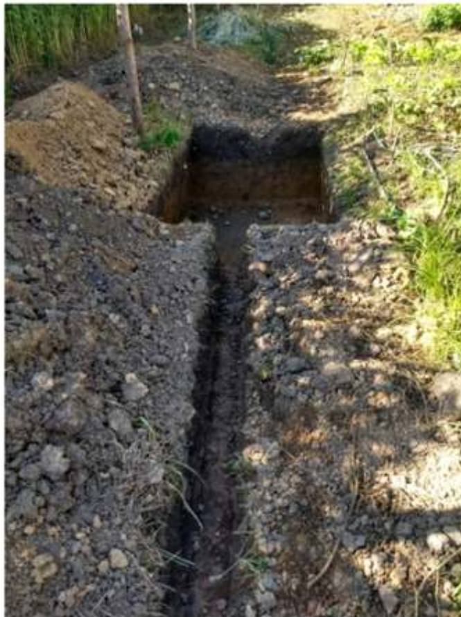
Figura 16: Foto da obra de drenagem na área baixa de um dos lotes da Bio-horta, incluindo canaleta para escoamento e pequeno sumidouro.
