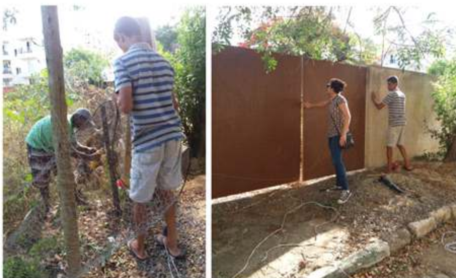
Figura 14: Fotos da instalação de portão em um dos lotes destinados a implantação da Bio-horta.
