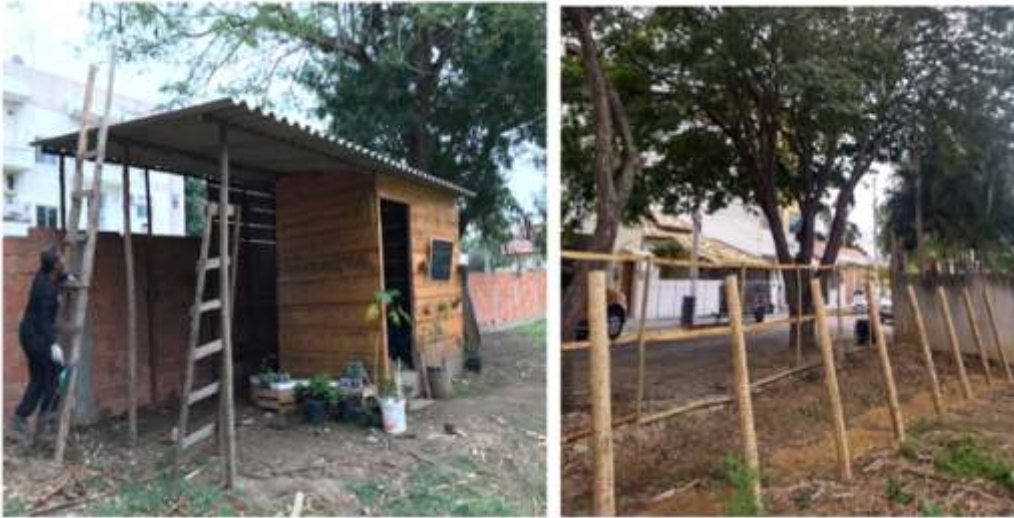
Figura 15: Foto (à esquerda) da construção do galpão e foto (à direita) de cerca e estruturas para tutoramento instaladas em um dos lotes destinados à implantação da Bio-horta.
