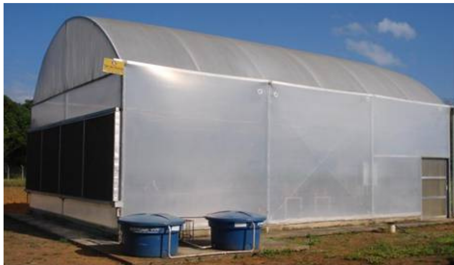
Figura 1: Casa de vegetação climatizada onde foram instalados os experimentos.
