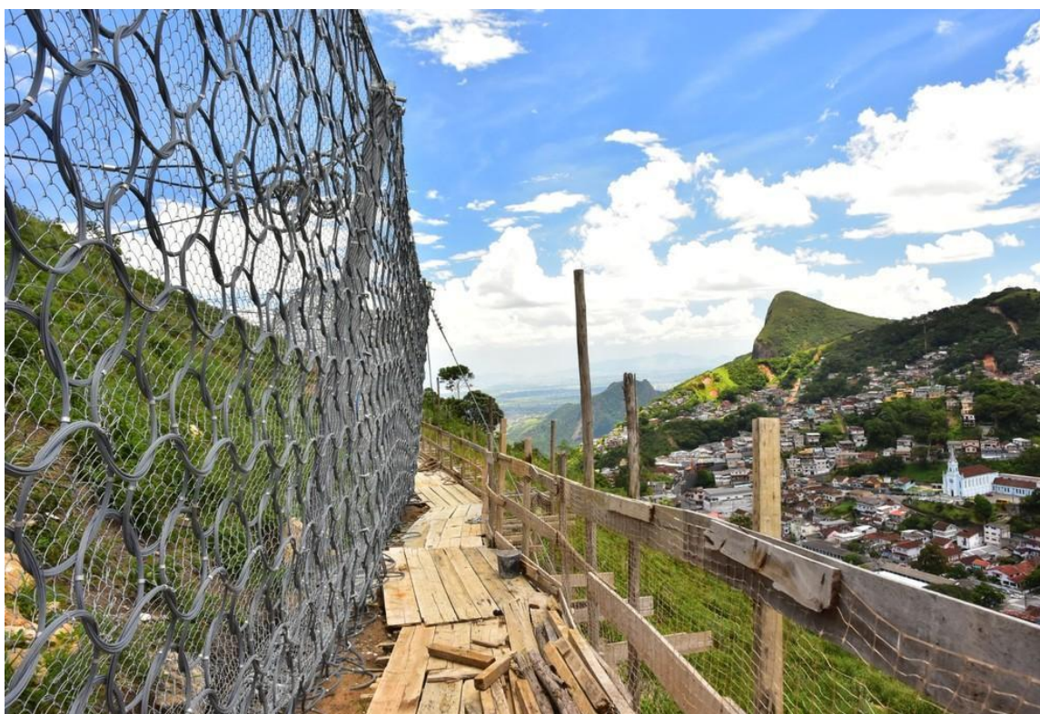
Figura 7: Telas de barreira dinâmica (contenção de encosta).
