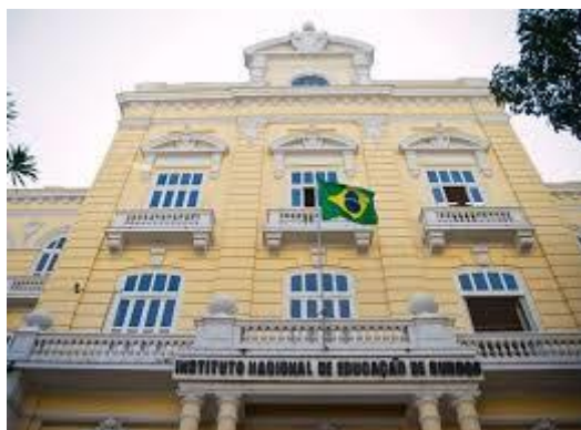
Figura 2 - Fachada do INES
