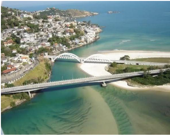
Figura 01: Pontes de acesso entre Barra de Guaratiba e a Reserva Militar
