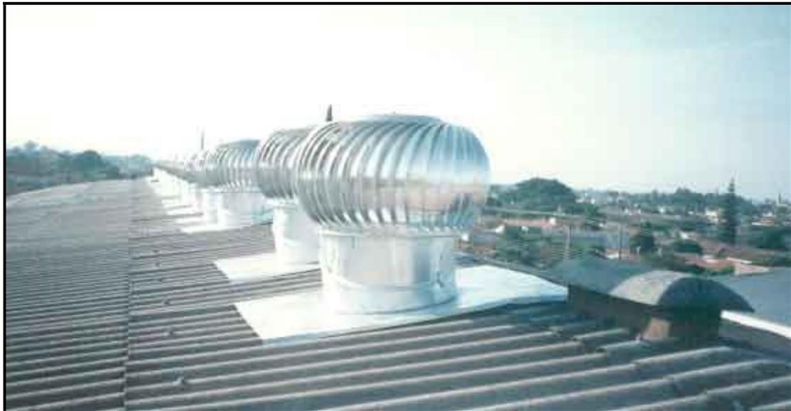
**Figura 1** - Instalação típica de exaustores eólicos.
