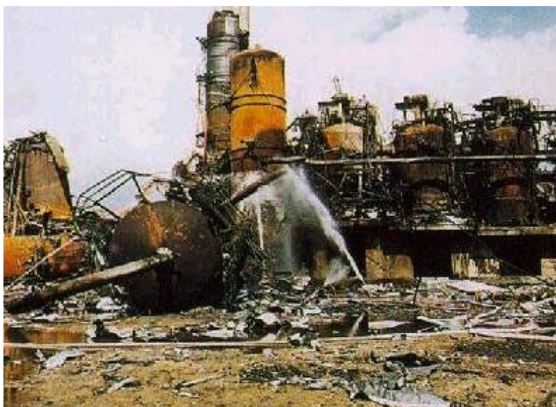
Figura 10 – Destruição da planta industrial da Nypro Ltda (Fonte: http://zonaderisco.blogspot.com , 2010)
