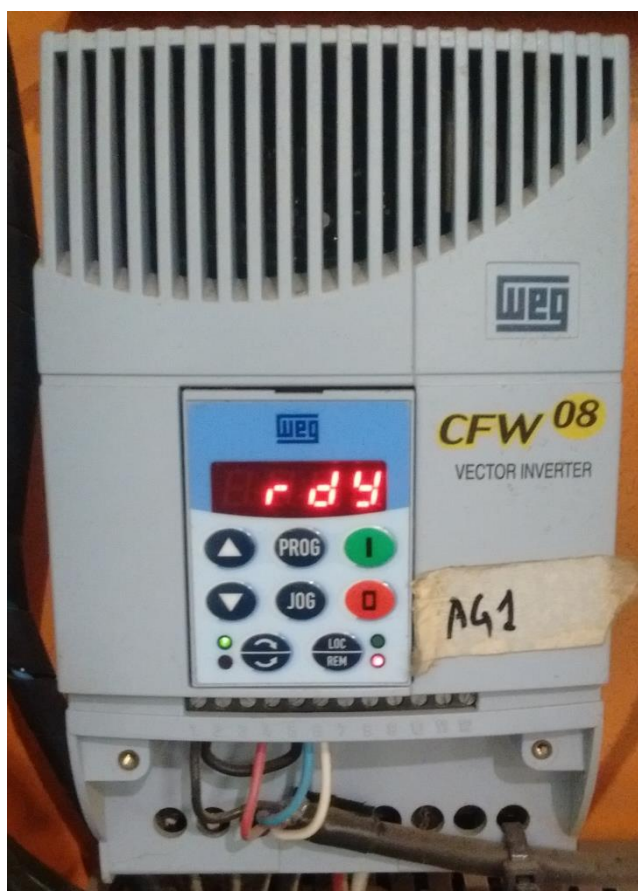
Figura 24 - Inversor de frequência. Fonte: o Autor
