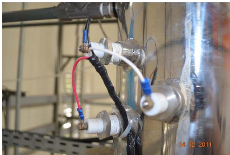
Figura 3.9 - Sensor de nível para tanque de pressão.
