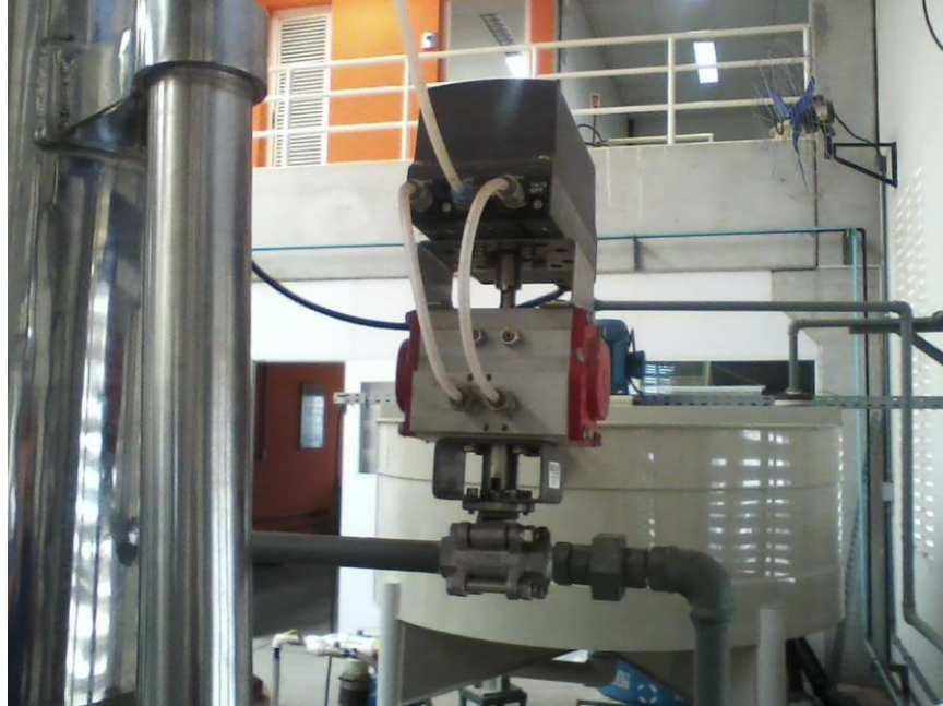
Figura 3.8 - Válvula de permeabilidade com esfera caracterizada.
