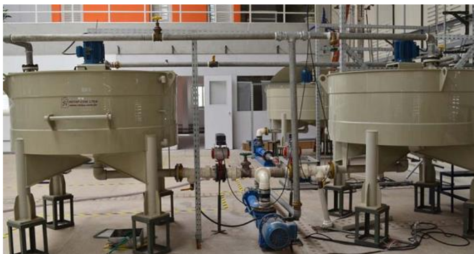
Figura 3.12 - Bomba helicoidal de deslocamento positivo (Bomba lama).
