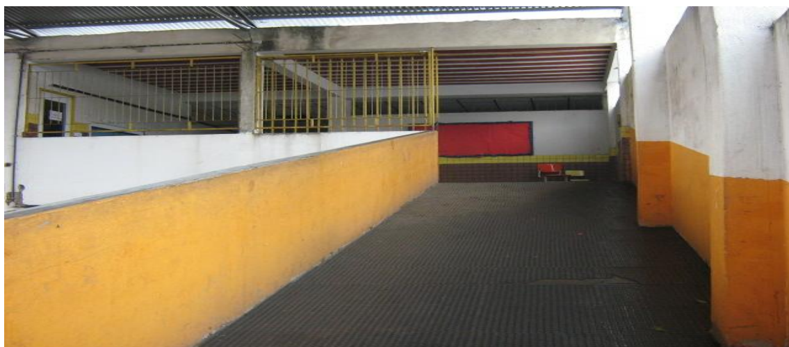
(Figura 3 – Rampa de acesso ao 2º pavimento)
