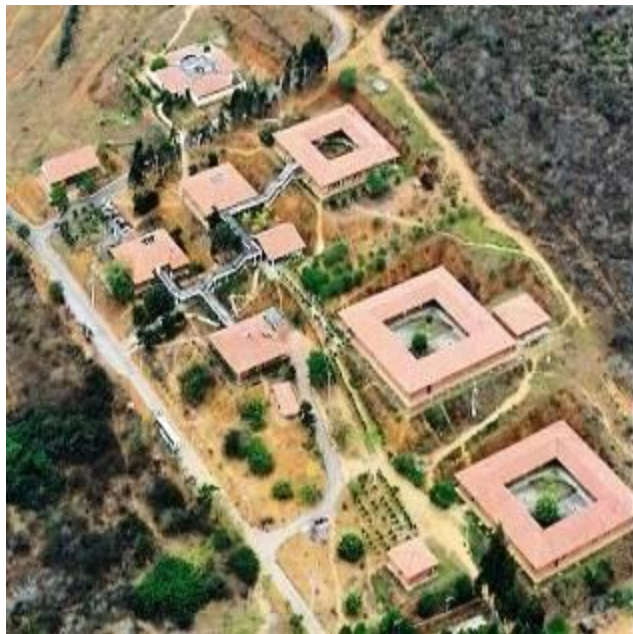
Figura 08 – Vista aérea do Campus Santa Inês
