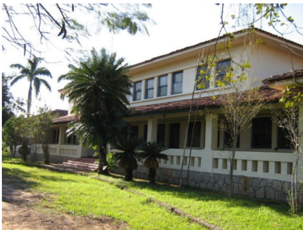
Figura 05 – Instalações da antiga ladeira da meteorologia, onde funcionou o CTED de 1966 até 1972 e o CTUR de 1973 até 1988. Hoje o prédio abriga o alojamento da EMBRAPA. (02/08/2007)
