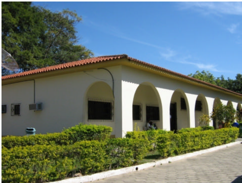
Figura 07 – Prédio anexo ao CTUR, construído à época da mudança para essas instalações, em 1988 (02/08/2007)
