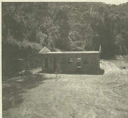
Futuras instalações da Agroindústria
