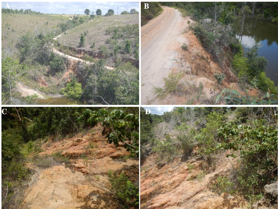
Figura 14 – Imagens de áreas degradadas no Acampamento Unidos Venceremos, 2016, na Fazenda Santa Maria II, Porto Seguro, BA. A e B Erosão na beira da estrada; C e D erosão na APP. Fonte: Rezende, 2016
