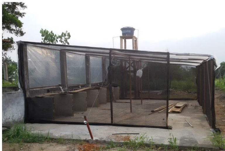
Figura 6: Casa de vegetação construída no viveiro do IT da UFRRJ
