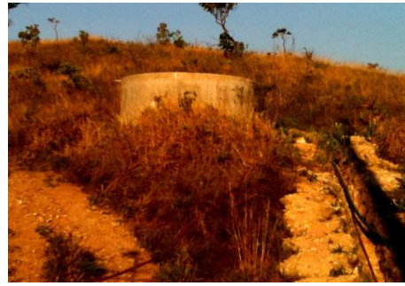
Figura 35: Caixa d'água 30.000 litros (2012)
