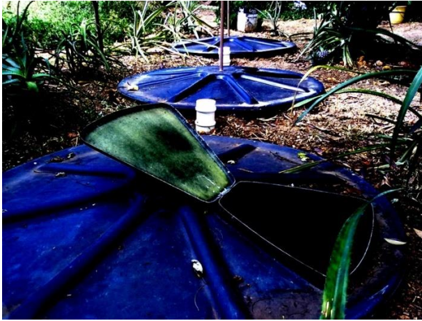
Figura 38: Detalhes da fossa Séptica Biodigestora (2011) (ângulo A)
