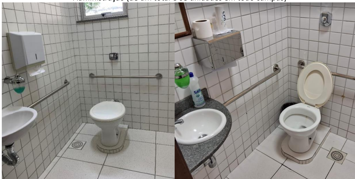
Figura 52 – Banheiro Acessível – Refeitório do ITR (a esquerda) e torre Norte (a direita) no curso de Administração (de um total e 08 unidades em todo campus)
