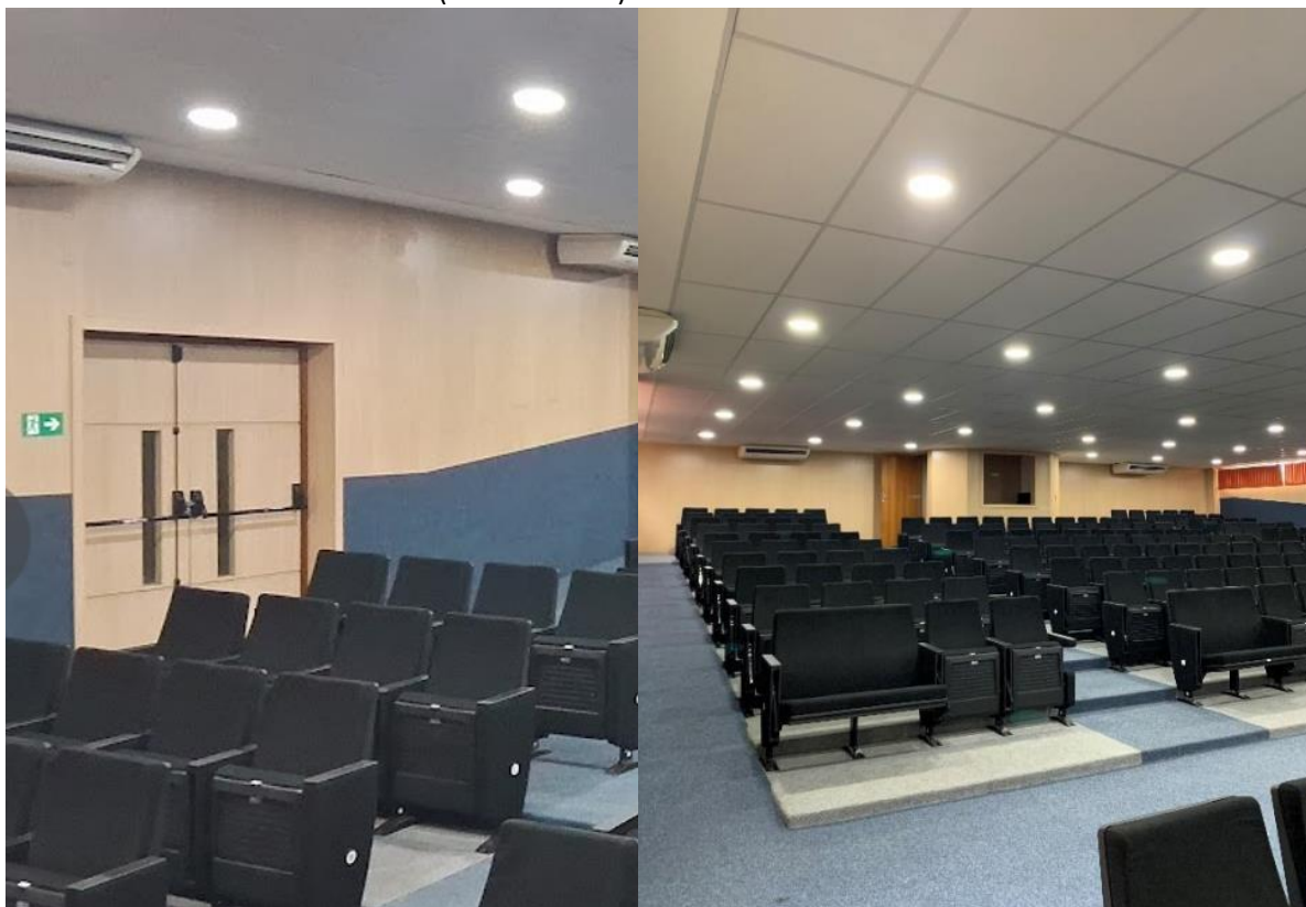
Figura 51 – Porta dupla corta fogo em rota de fuga (foto à esquerda) e acento reservado à obesos (foto à direita) do auditório do ITR
