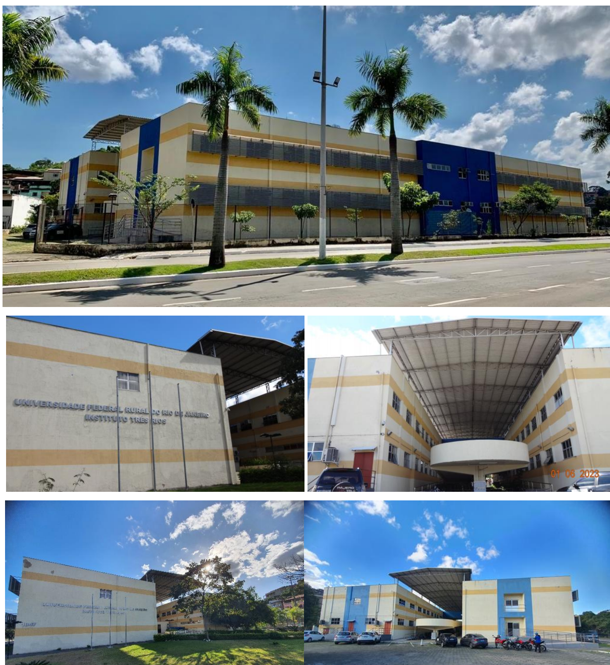
Figura 20 – Fachadas do prédio do Instituto Três Rios da UFRRJ
