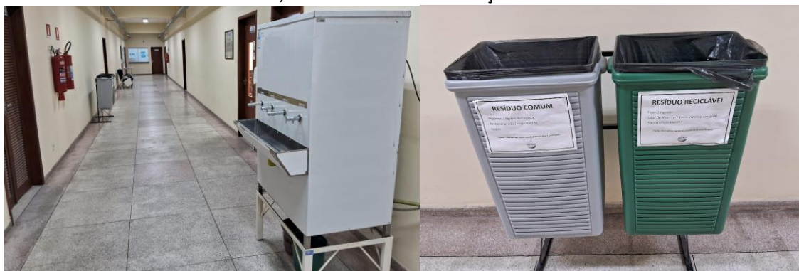
Figura 42 – Detalhe dos corredores: bebedouro (a esquerda) e lixeiras seletivas (a direita) na Torre Norte, do curso de Administração do ITR.
