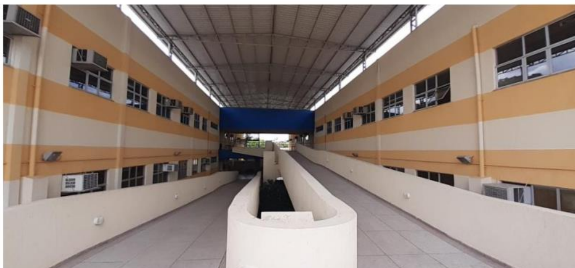
Figura 48 – Rampas de acesso ao segundo pavimento - Prédio Principal do ITR
