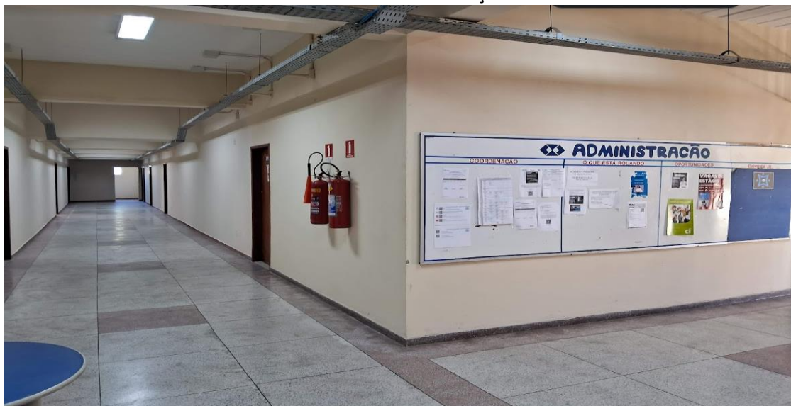
Figura 41 – Corredores e áreas comuns da Torre Norte, segundo piso – Área de circulação entre as salas do curso de Administração do ITR
