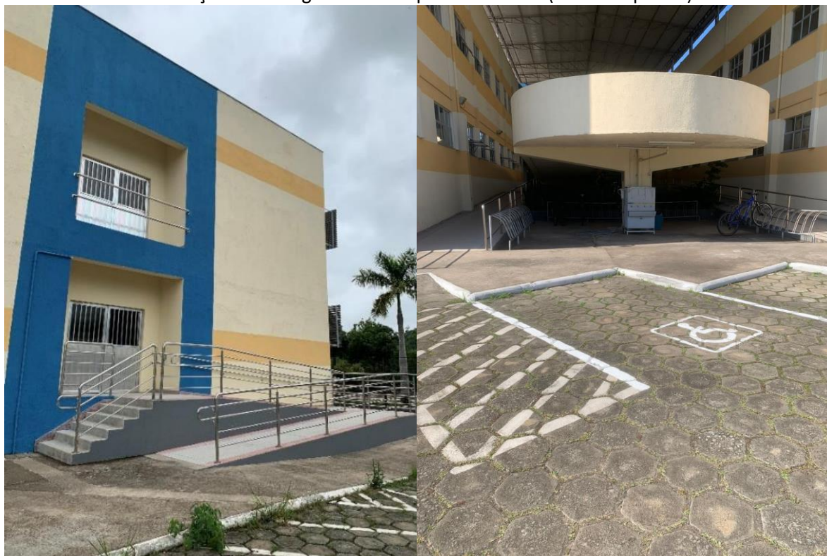
Figura 49 – Rampas de acesso ao pavimento (foto à direita) e demarcação de espaço adicional de circulação entre vagas e reserva para deficiente (foto à esquerda)
