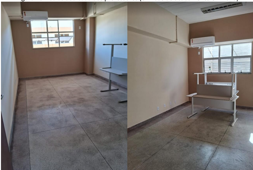
Figura 28 – Salas dedicada dos professores (em fase de acabamento em 2023)
