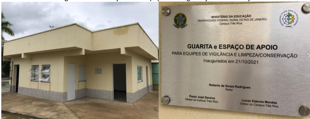
Figura 37 – Instalações das equipes de Segurança e Conservação
